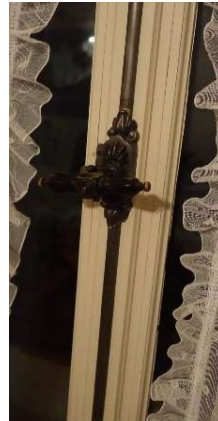
Basculegetriebe mit Hornolive
